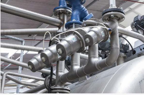
Su Giriş Vanaları ve Tuz Çözeltili Giriş Vanası Water Inlet Valves and Salt Solution Inlet Valve
